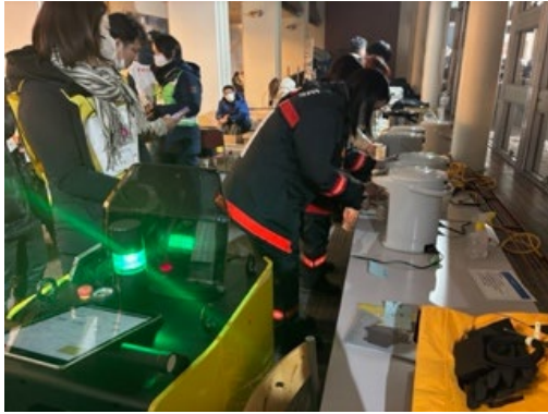
エントランスで燃料電池発電機(写真左手前)から給電した電気ポットを使用する様子
